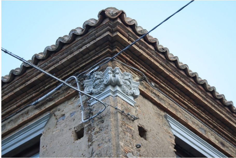
Foto n. 6 b – coppia di bafometti in soluzione d'angolo in un edificio del centro storico
